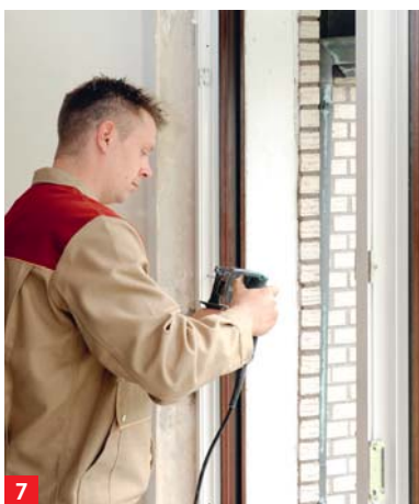
Saubere, präzise Befestigung des Fensterrahmens
