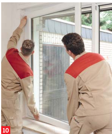
Einhängen des neuen Fensterflügels
