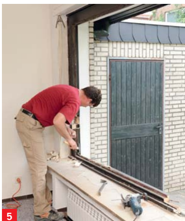
Ausbau des alten Fensterrahmens
