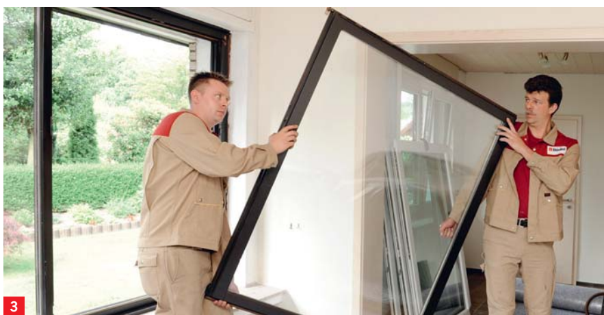
3 Herausnahme des alten Fensterflügels
