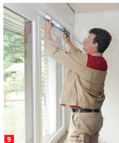
Winddichte Versiegelung von innen und außen erfolgt zum Schluss der Montage
