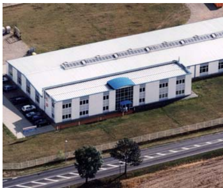
SpreeWa Duben, Brandenburg
