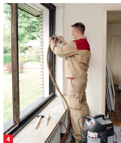
4 Demontage des alten Fensterrahmens – modernstes Schneidegerät mit Absaugung verhindert jede Beschädigung an Putz und Tapete
