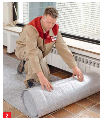
2 Sorgfältiges Abdecken aller Montagestellen und Laufwege ist selbstverständlich
