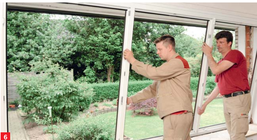
Einsetzen und Ausrichten des neuen Fensterrahmens
