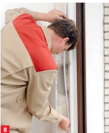
Abdeckung und Verleistung der inneren Anschlussfugen
