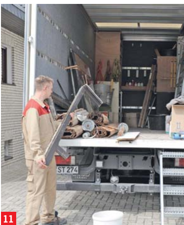
Entsorgung der alten Fenster im Montagewagen
